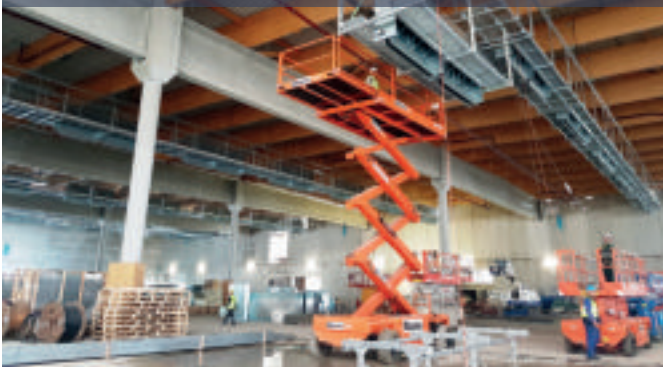
Montaje de los módulos siFramo Catwalk
