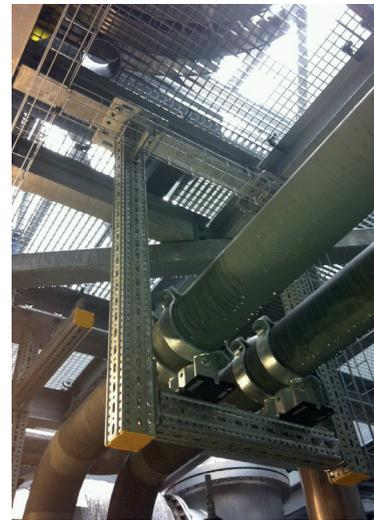
Foto de archivo: Sistema modular atornillado siFramo para montaje rápido de estructuras secundarias
