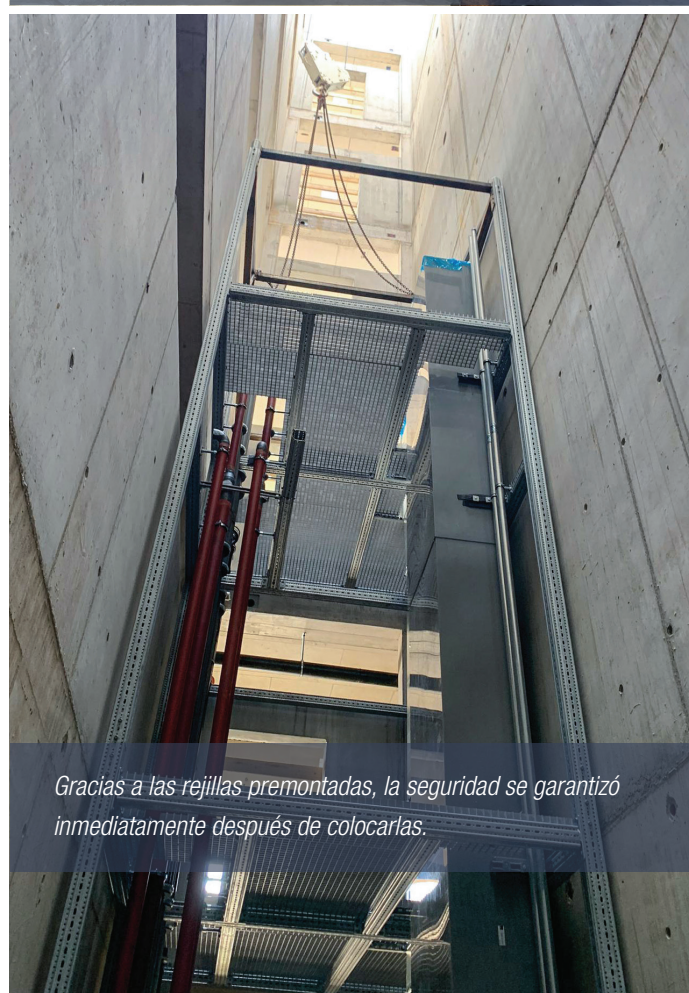
Dimensiones de los módulos: 4,2 x 2,5 m, altura hasta 8,4 m
